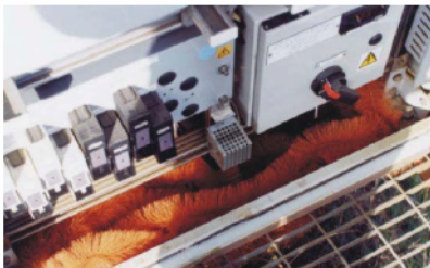
Quatre ADEREP SOL à l'entrée des câbles dans une armoire de commande
